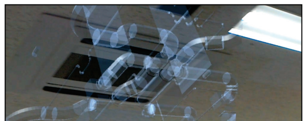
図 3 MR デバイス内の天井隠蔽部の部位表示 (配管・設備) の様子
