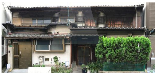
図7 例外的な長屋の例(長屋番号19, 下屋の屋根が入り組み、住戸ごとに下屋形状が全く異なる)
