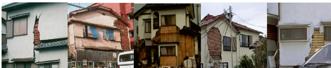
図2 Bランク被害画像群
