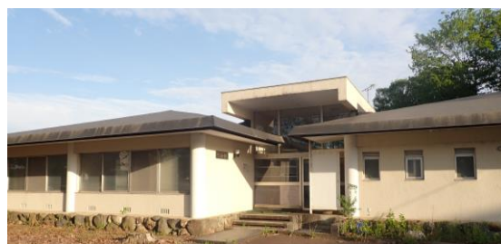
写真 1 心和館の正面玄関の外観
