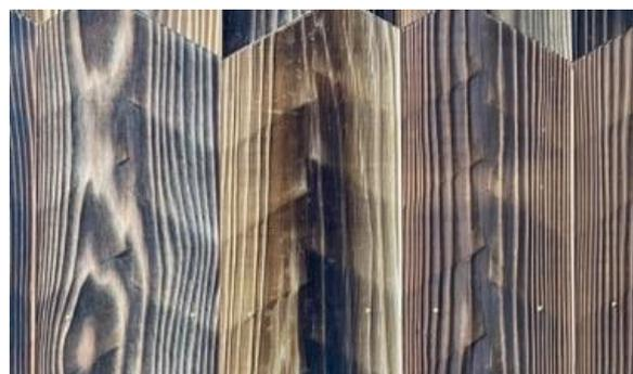
図11 レーザー彫刻加工によるなぐり板の実装
