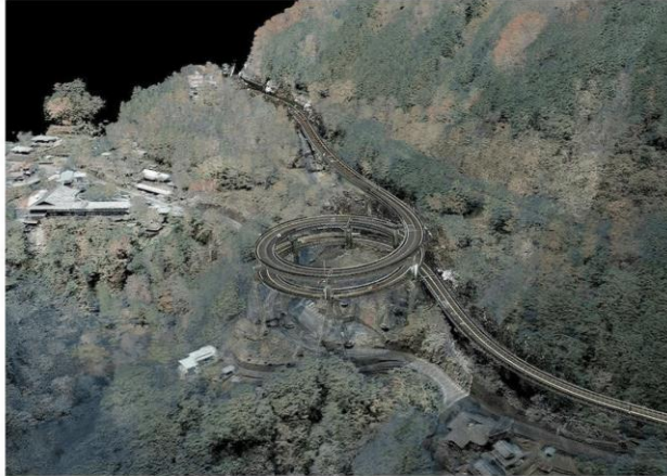
河津七滝ループ橋の点群データ
