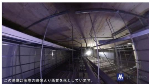
360°パノラマカメラを搭載したドローンをOsaka Metroの ホーム天井裏に侵入させ、内部をビデオ撮影 (画像：アイ・ロボティクス)
