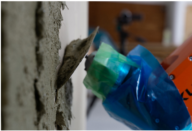
図9 ロボットアームによる土塗りの様子
