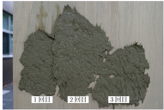
図10 ロボットアームによる土塗り後の壁面
