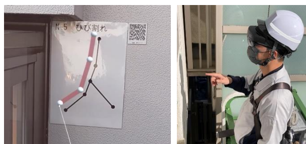
図1 外壁劣化診断結果入力システムの操作の様子
