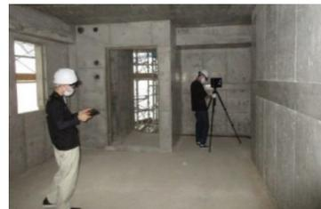
図1 専用カメラによる工事現場での360°画像撮影
